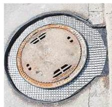
Eine Glasfaserschicht verbindet Beton und Asphalt miteinander.
