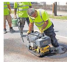
Letzter Arbeitsschritt: Der Asphalt wird verdichtet.
