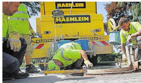
Die Arbeiter nivellieren die Höhe des Kanalschachts.
