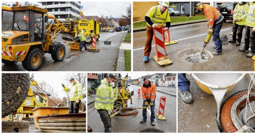
Claus-Dieter Haenlein und sein Team aus München bestücken die Ortsdurchfahrt von Königsbrunn im Zuge einer versuchsweisen Sanierung mit insgesamt elf neuen, konisch geformten Verbund-Kanaldeckeln. Vorbei ist damit das lästige Rumpeln und Klappern durch losgerüttelte alte Schachtrahmen – was vor allem auch die Anlieger freut. Weitere Fotos auf [www.hz-online.de/bilder](http://www.hz-online.de/bilder). *Fotos: Sabrina Balzer*
