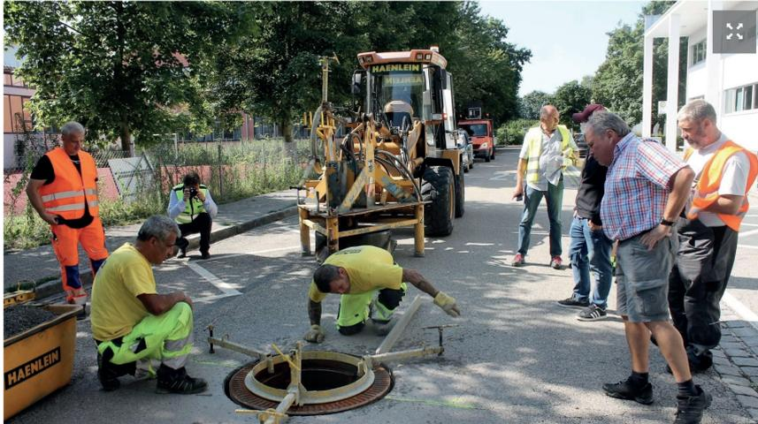
Passgenau wird der neue Schachtring auf die bestehende Einstiegs Luke gesetzt. © DC-X
