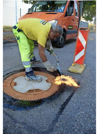
Am Ende hilft ein Flammenwerfer, die abdichtende Bitumenmasse mit Schacht und Straßenkörper zu verbinden.
